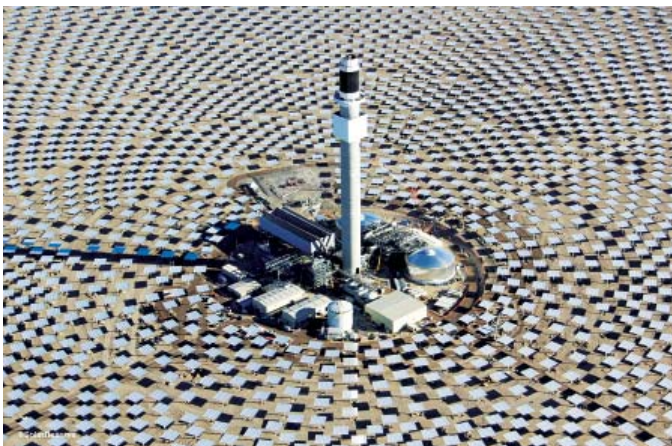
Башня Crescent Dunes высотой 640 футов (192 м) в Неваде собирает более 100 МВт мощности. Эта мощность будет передаваться в Лас-Вегас по линии ON Line в 2014 году.
