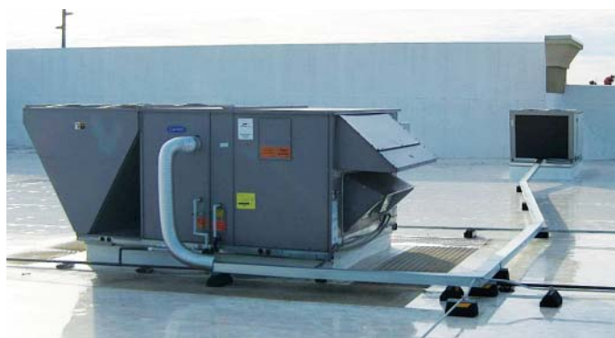
Установка накопителя Ice Bear на крыше магазина Kohl's в Реддинге.
