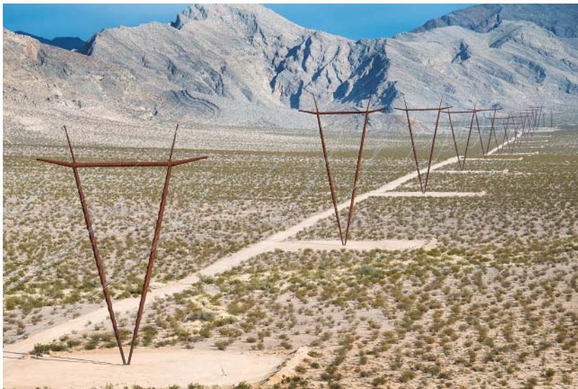
Опоры линии ON Line имеют заметно меньшее влияние на окружающую среду благодаря небольшому бетонному фундаменту и опорам с четырьмя оттяжками.
