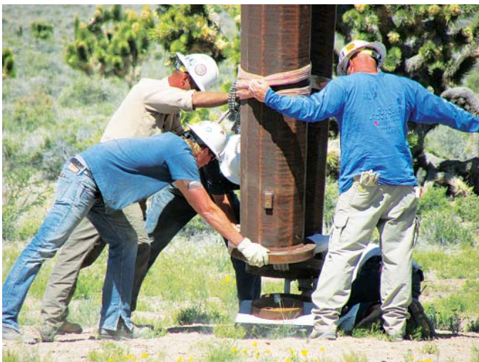
Благодаря использованию усилия от преднапряжённых оттяжек, опоры линии ON Line опираются только на опорные пластины, которые крепятся к нижней части опоры двумя шпильками длиной 15 см.
