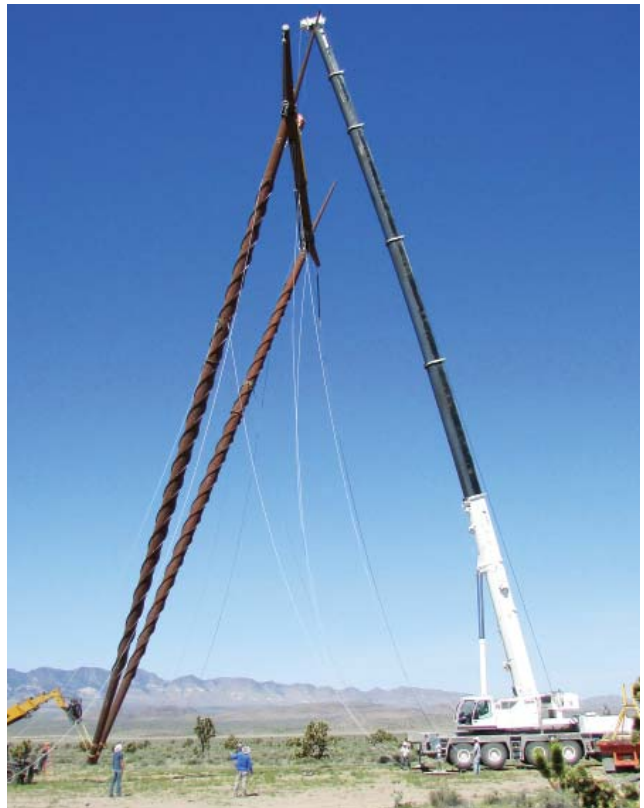
Из-за высоты конструкций примерно 400 рабочих были заняты на различных работах по сооружению линии ON Line.
