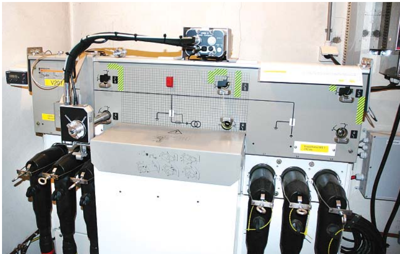
Применение электропривода LINAK на распределительном устройстве (вид спереди).
