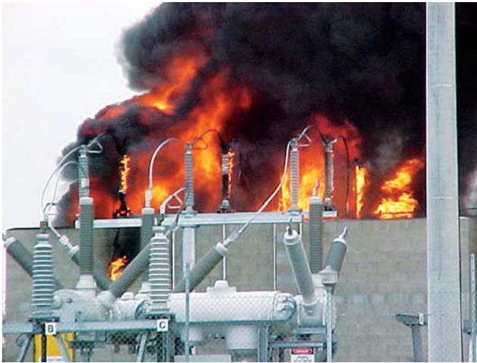
Отказ ввода с бумажно-масляной изоляцией привёл к возгоранию трансформатора 80 МВА. К счастью, пожар был локализован внутри шумозащитного экрана.
