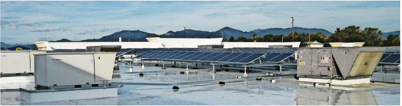
Установка солнечных батарей и накопителей Ice Energy на крыше магазина Kohl's для смещения пика производства электроэнергии.
