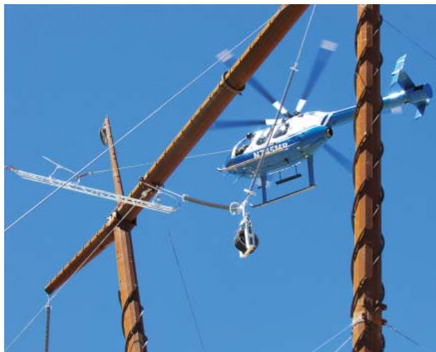
При сооружении линии с помощью вертолёта было натянуто в общей сложности более 1100 миль проводов и грозозащитных тросов. Как видно на фото, наиболее сложной задачей была натяжка провода средней фазы.
