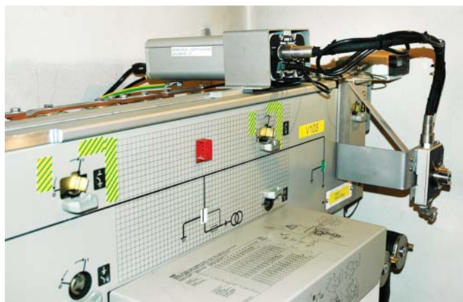
Применение электропривода на компактном распределительном устройстве (вид сбоку).
