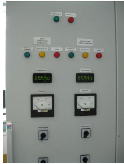
Основная система шкафа СКИВ-ЭР строится на базе измерителей электрического сопротивления изоляции цепей MIDAS RIMD2 и знаковинтезирующих индикаторов CCD CD-RS422-PM-07.
