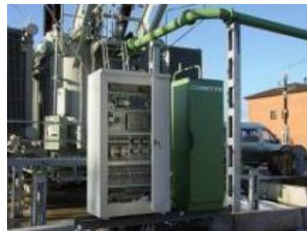
Система мониторинга трансформаторного оборудования
